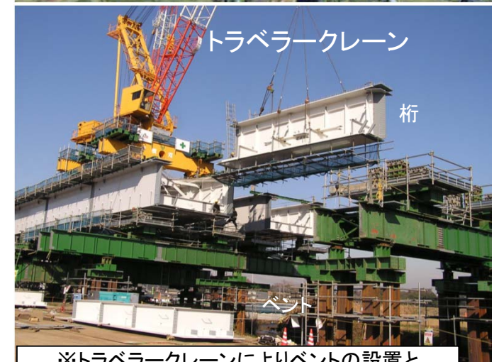
※トラベラークレーンによりベントの設置と桁架設を繰り返しながら前進
