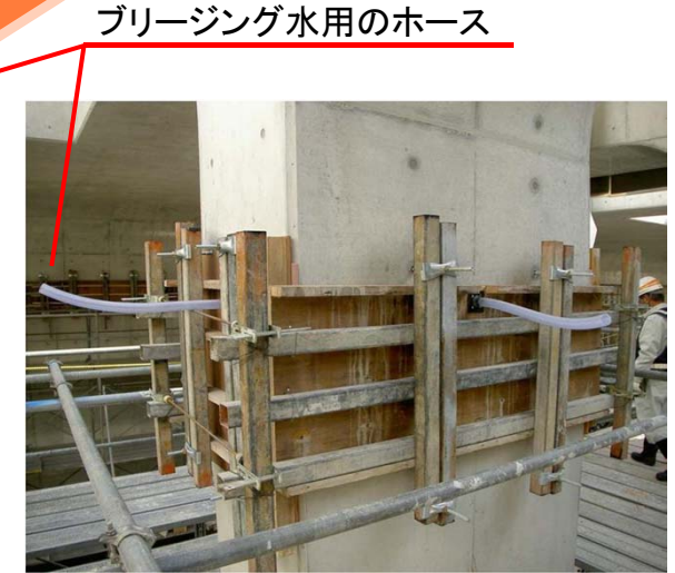
中柱部間詰型枠設置状況
