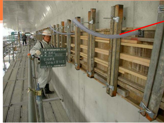
側壁部間詰型枠設置状況
