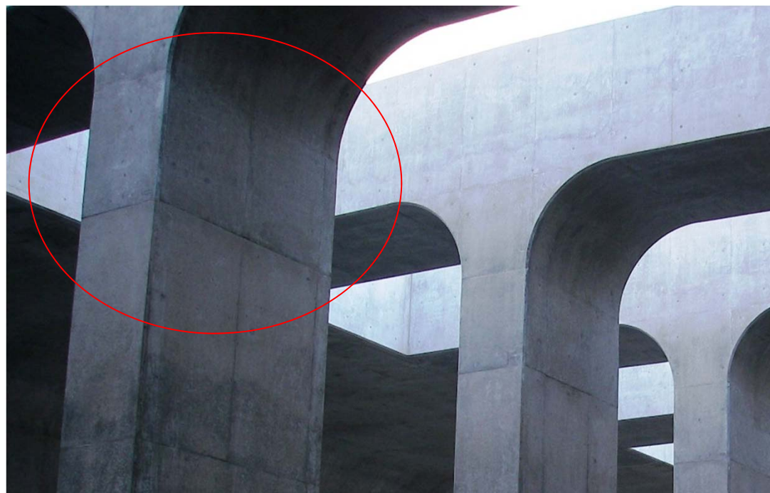
型枠取り外し後の状況
