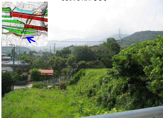
現況状況写真
