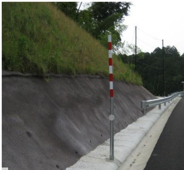
③ スノーポール + 視線誘導標
