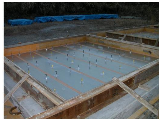
すべり性能試験状況
