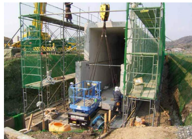
プレキャストカルバートボックス施工状況
