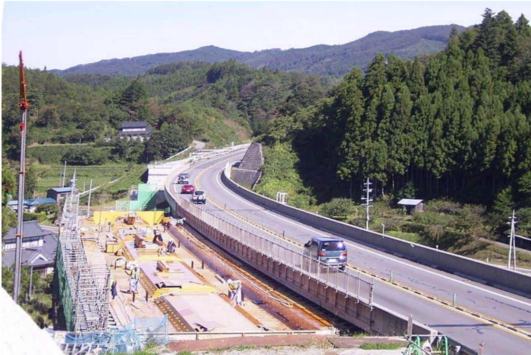
磐越自動車道 寺内橋
