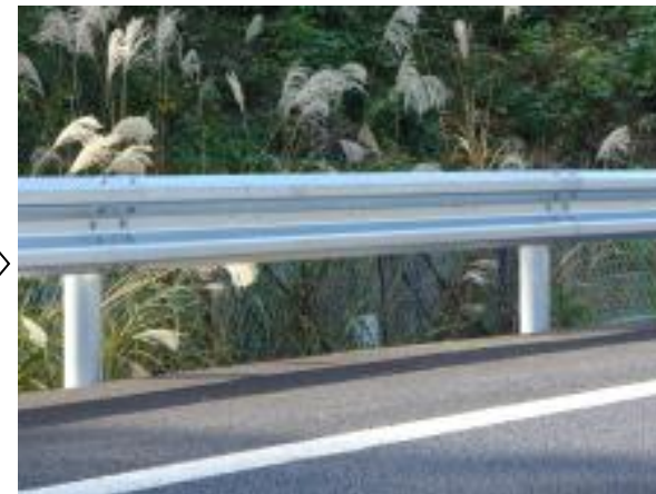
⑤設置 現場へ運搬後、設置
