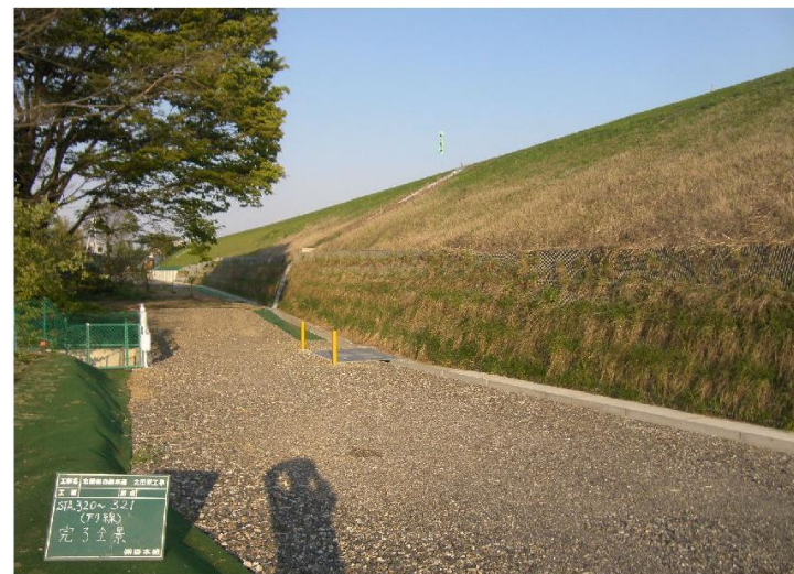
盛土完成写真
