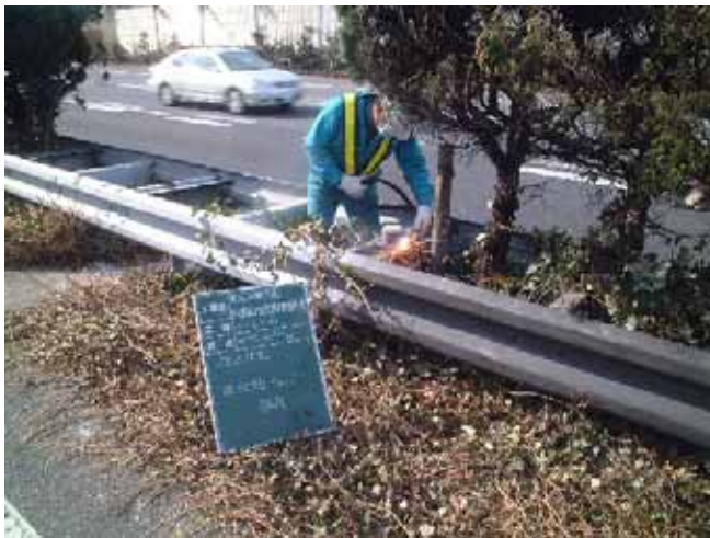
既設支柱頭部20mm切断
