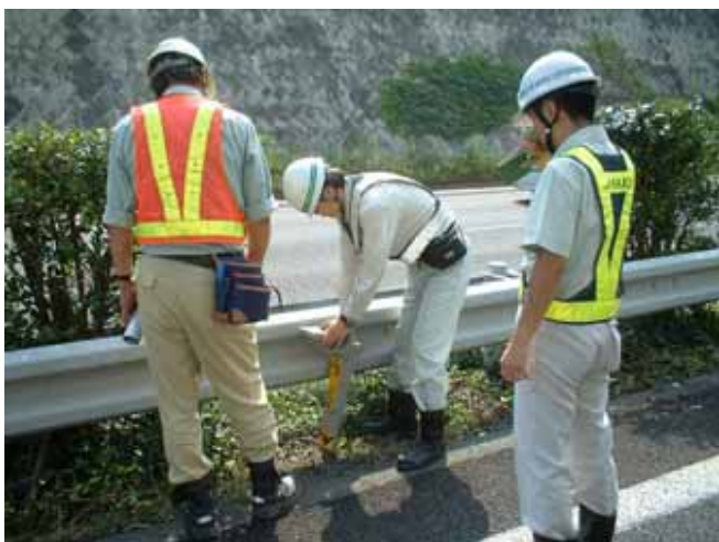
光ケーブルの探査
