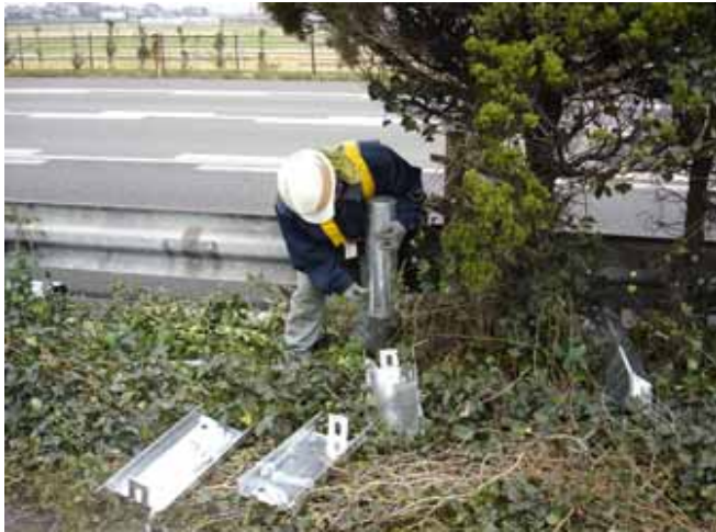
嵩上げ支柱( 127)の設置
