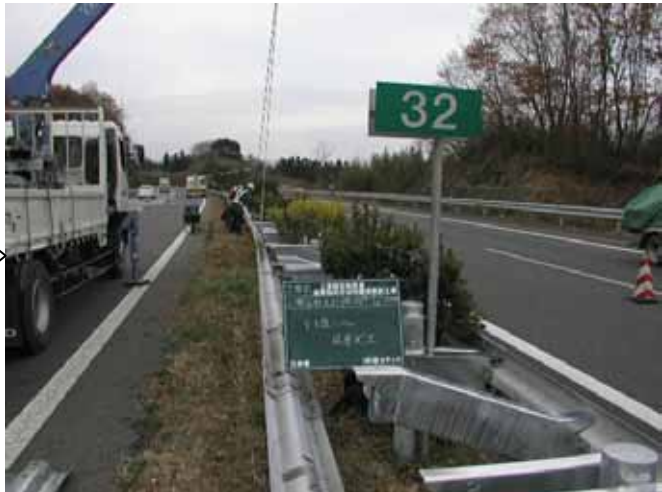
新材ブラケット、既設レール設置
