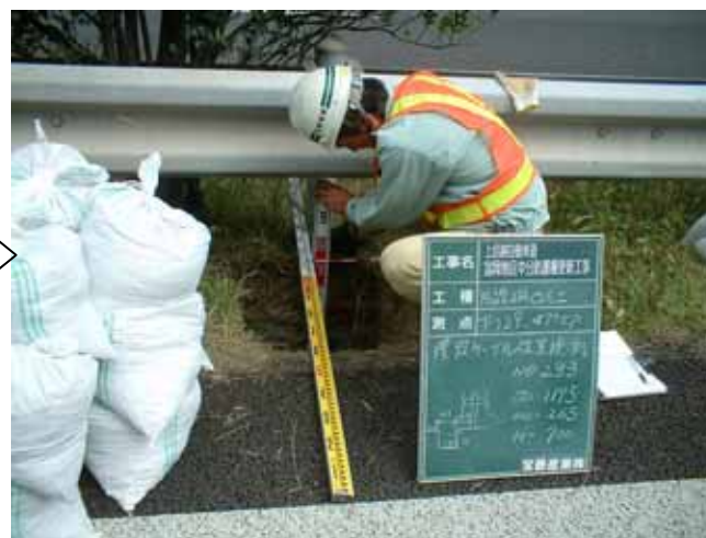
試掘による光ケーブルの位置確認
