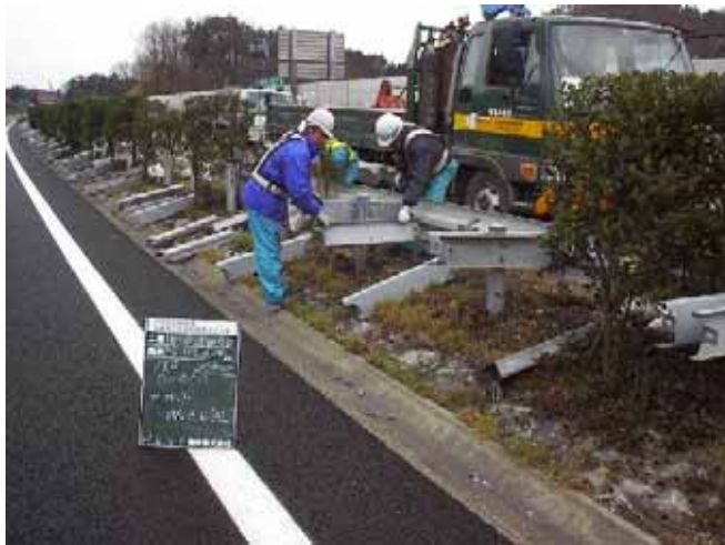
既設レール、ブラケットの撤去
