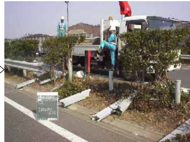
既設支柱の引抜き
