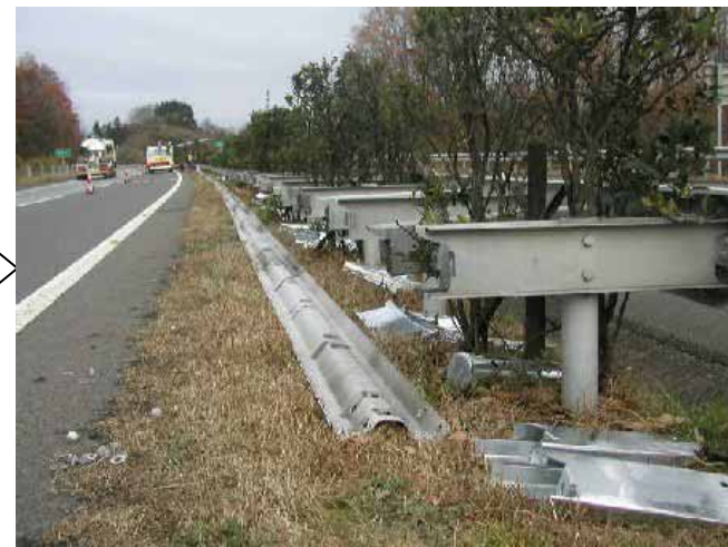
既設レール、ブラケット撤去
