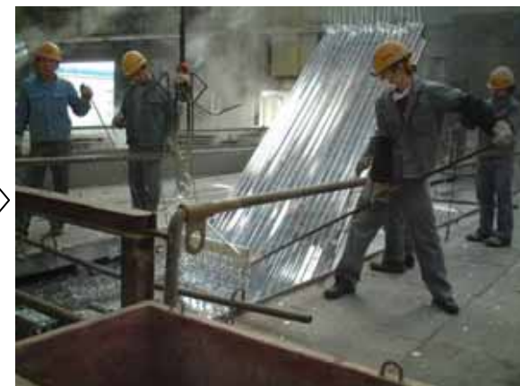
亜鉛めっき 亜鉛めっき工場へ運搬し めっき処理
