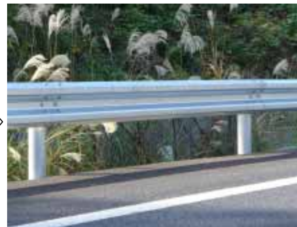
設置 現場へ運搬後、設置
