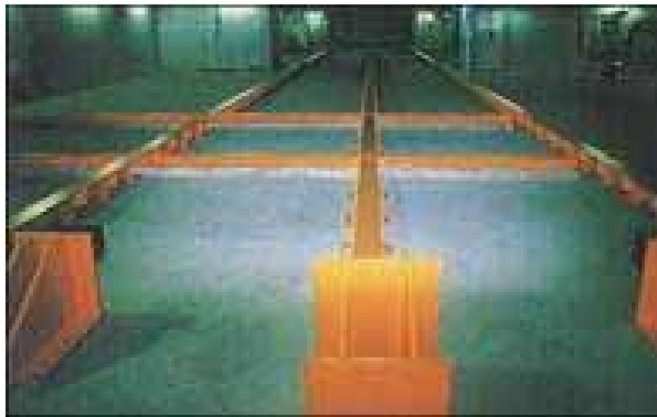
レール敷設状況
