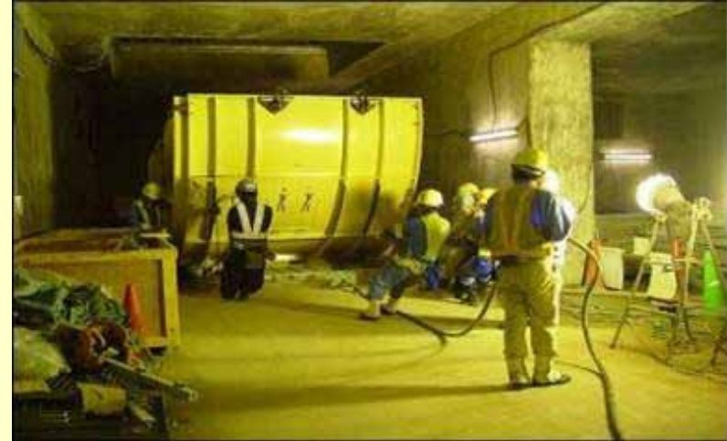
換気設備の搬入状況
