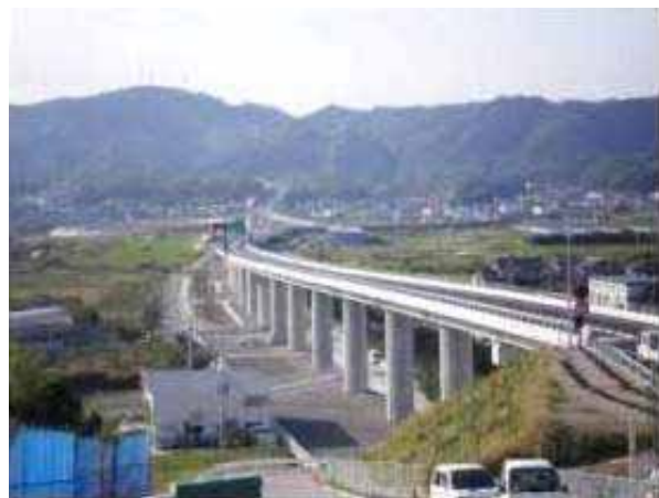
みなべ高架橋
