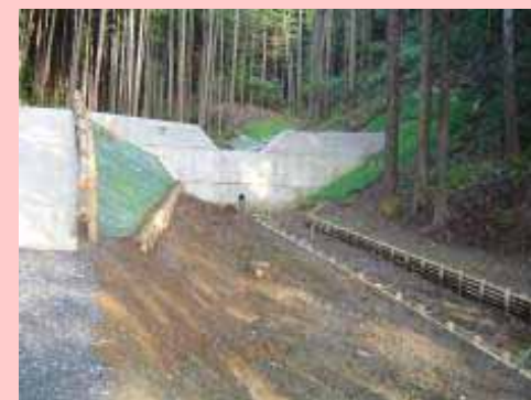
土石流対策工事状況
