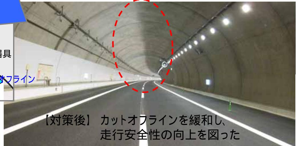
新たに開発した反射板により、照明器具上方の覆工部に照射している光をより遠方へ照射することが可能になり、カットオフラインが緩和
