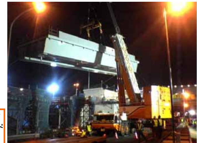
の550tクレーンによる架設
