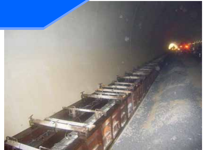
セットフォーム工法(型枠設置状況)
