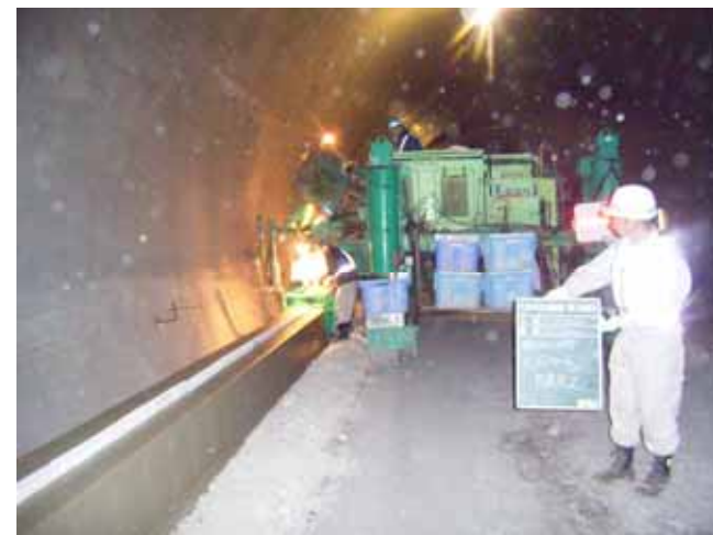
スリップフォーム工法(コンクリート打設状況)
