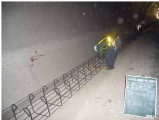
スリップフォーム工法(鉄筋設置状況)
