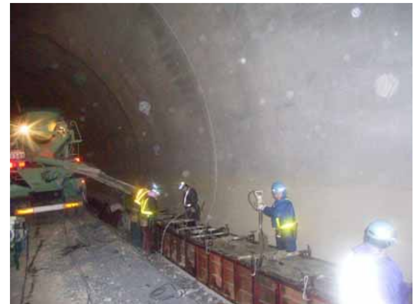
セットフォーム工法(コンクリート打設状況)
