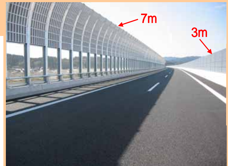
7m、3mの設置状況
