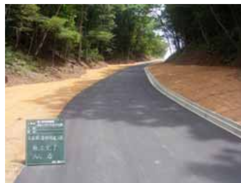
取付道路(中間部)
