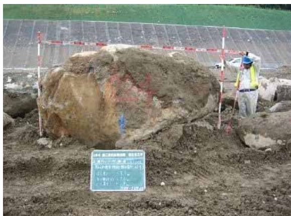
転石発生状況(切土場)
