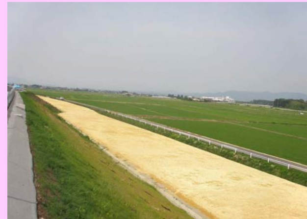
無機質副産物施工写真
