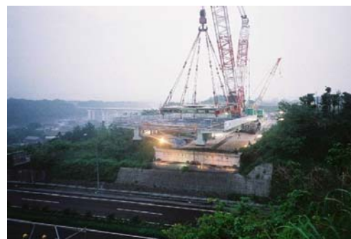
▲ 架設状況(反対側橋台より)
