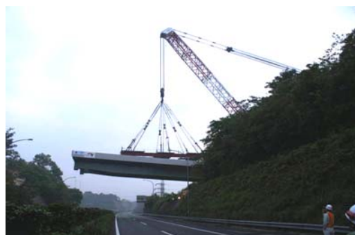
▲ 架設状況(東名上より)
