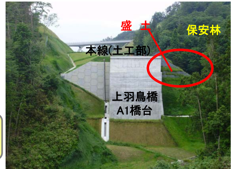
施工後(上羽鳥橋側より)
