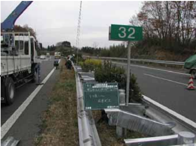
新材ブラケット、既設レール設置
