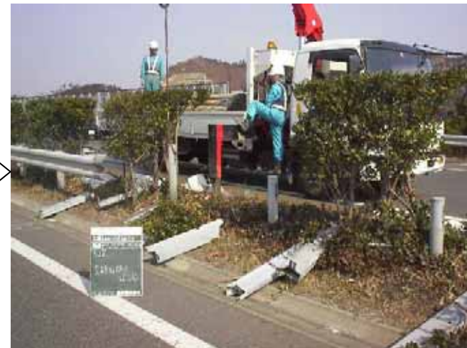
既設支柱の引抜き
