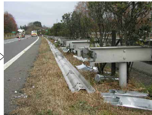
既設レール、ブラケット撤去
