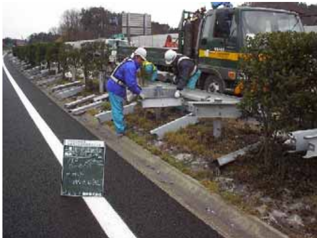
既設レール、ブラケットの撤去
