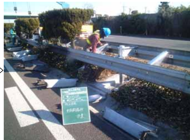
新材ブラケット、既設レール設置
