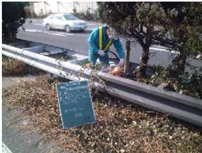
既設支柱頭部20mm切断
