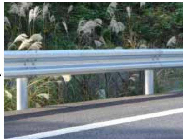
設置 現場へ運搬後、設置
