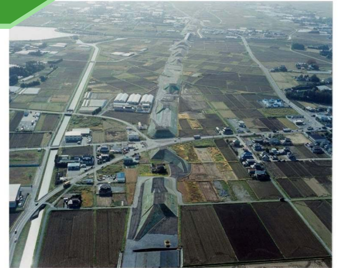
参考写真ー隣接カルバートボックス载荷盛土 施工状況
