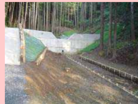
土石流対策工事状況
