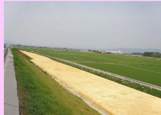
無機質副産物施工写真
