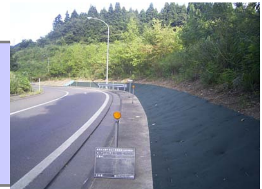
マルチングシート施工例
