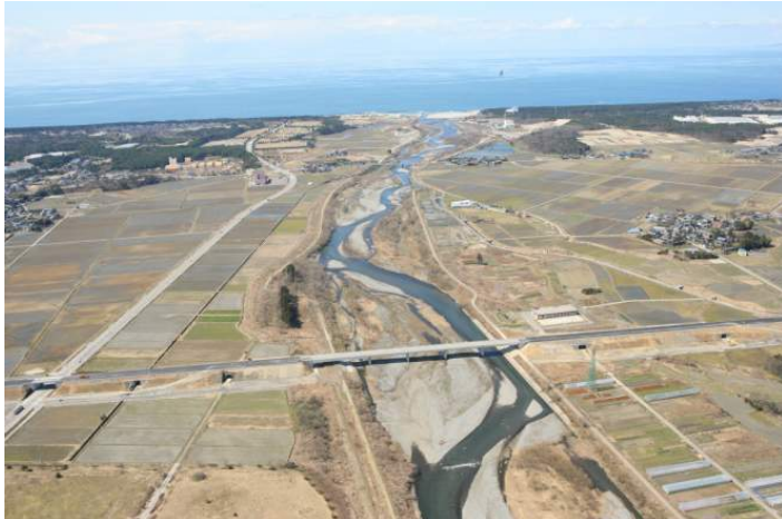
胎内川橋付近
