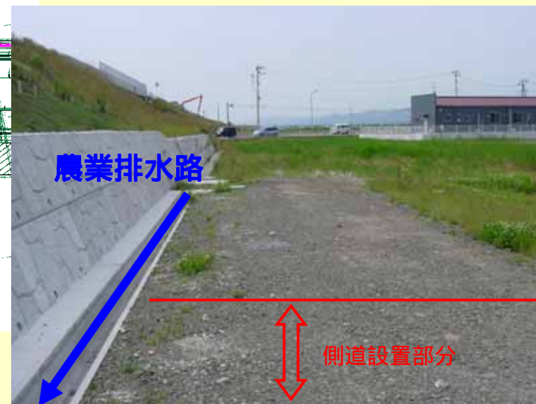
写真 側道の設置状況
