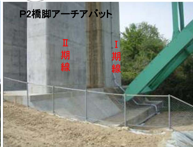
水平反力調整状況
