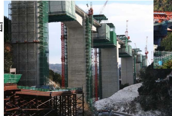
複数の張出し架設ワーゲンによる施工
