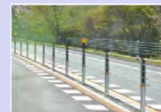
ワイヤロープ設置
