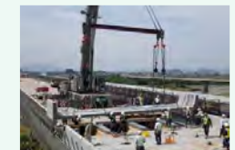
床板取替え工事
