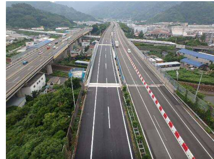
施工完了 (H28.7)
