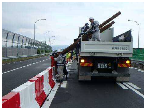
中央分離帯の移動防止強化
