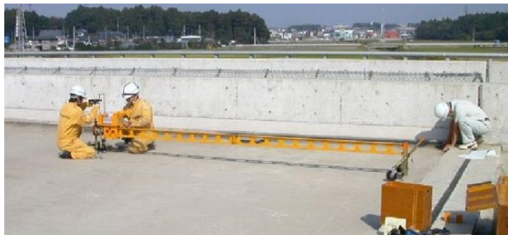
プロフィールグラフによる測定
