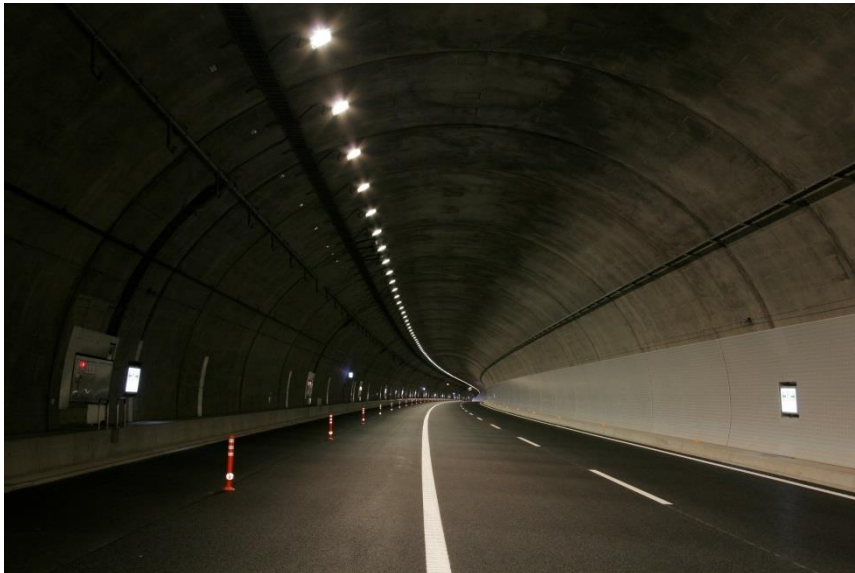
内側2車線運用(伊佐布トンネル上り)
