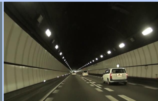
照明状況 (対称照明方式)
