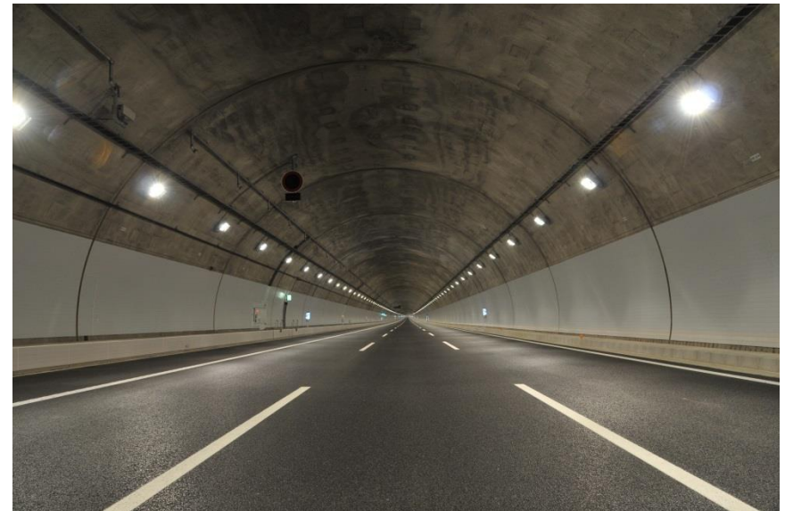
2車線+付加車線運用(粟ヶ岳トンネル上り)
