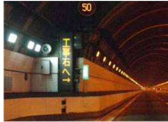
トンネル内情報板の使用
