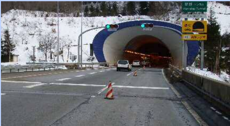
トンネル手前にテーパーを設置した規制状況
