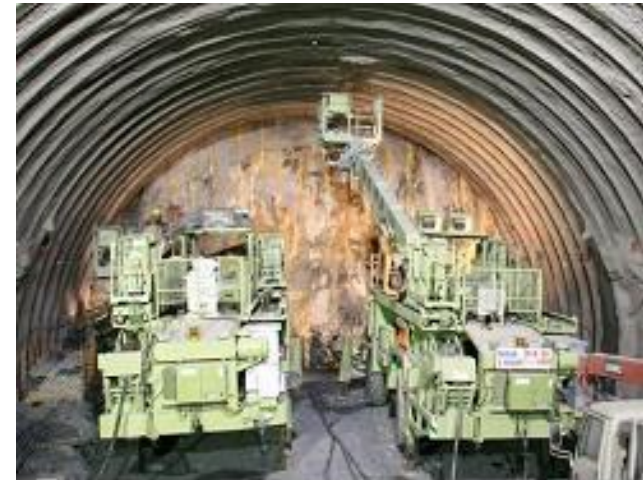
掘削機械の2セット化
