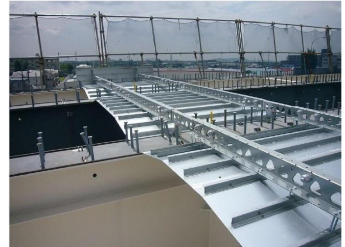
コンクリート床版の埋設型鋼製パネルの施工状況
