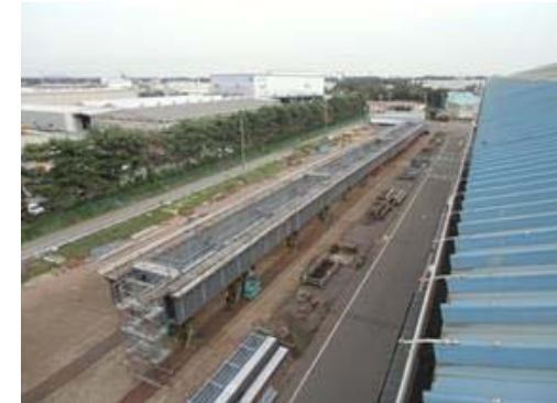
川北橋 仮組立状況
