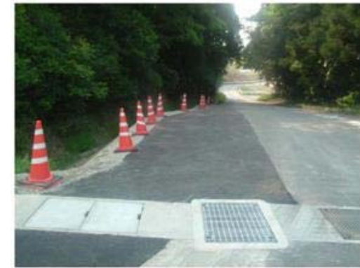
隅切り部を拡幅した桁搬出路
