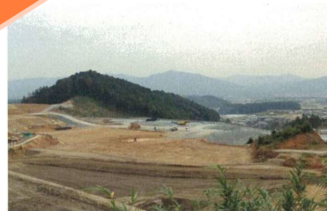
長篠設楽原PAの盛土施工状況
