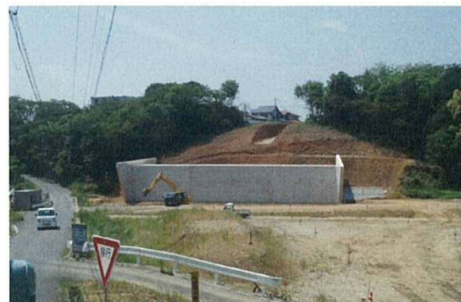
県道豊川新城線の盛土施工状況
