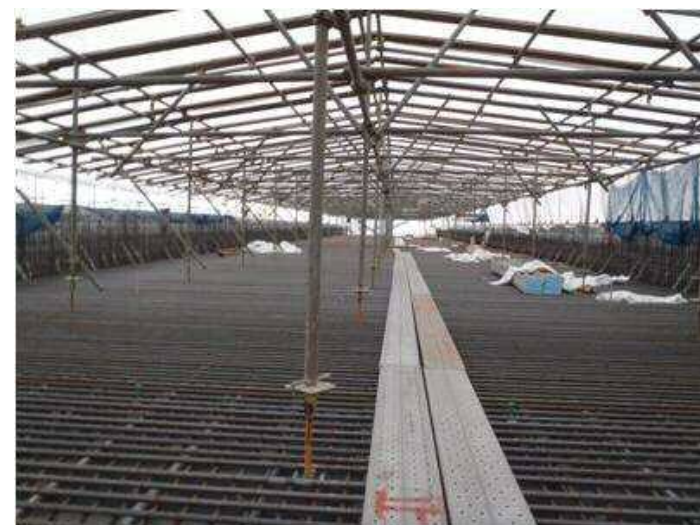
仮設屋根内部状況
