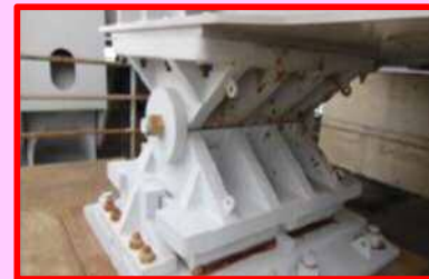
既設トラス桁支承
