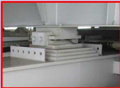
既設道路桁支承
