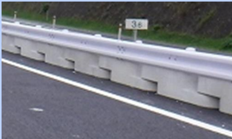
置き式ガードレール設置状況
