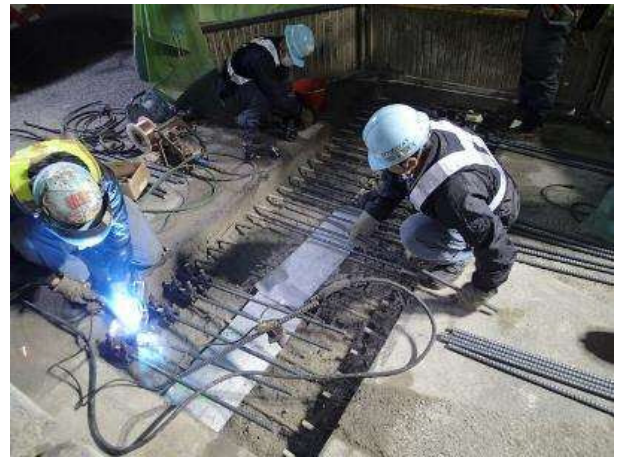
床版連結(上側鉄筋のみ接続)
