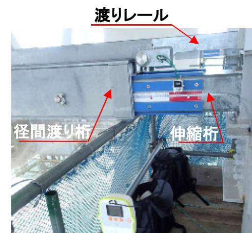
実橋実験による伸縮確認等の状況
