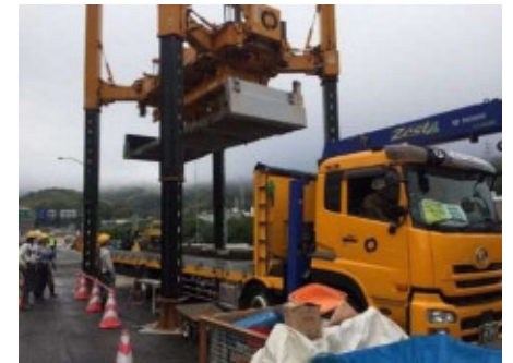
①運搬車両から載せ換え(リフター装置)
