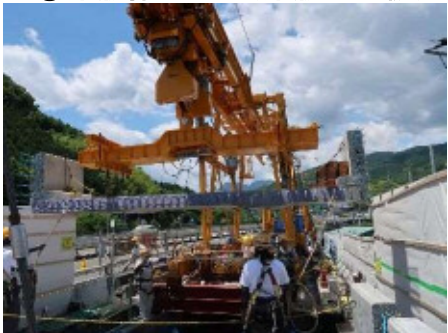
④床版据え付け(床版取替機)
