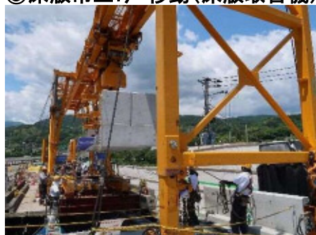
③床版吊上げ・移動(床版取替機)
