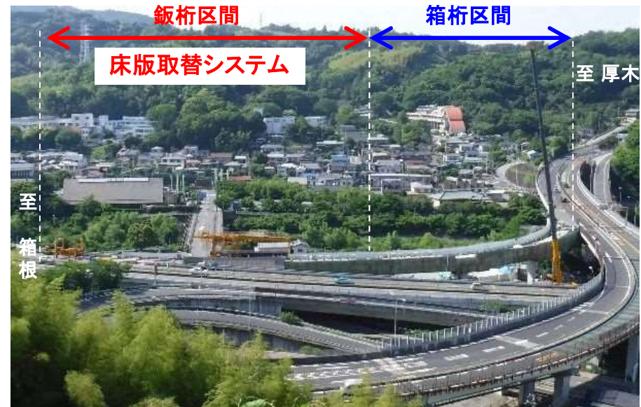
2区間同時施工
