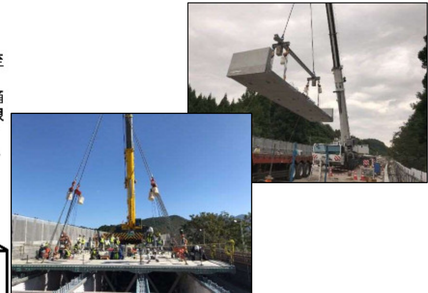
トラッククレーン施工(例)
