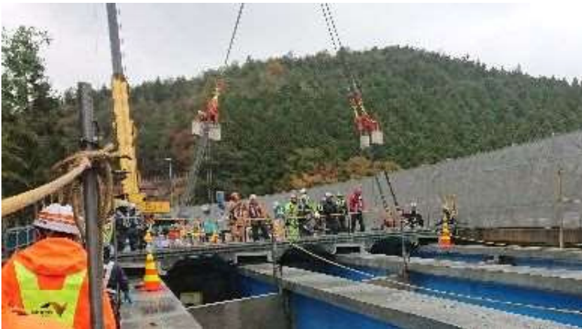
キャップスラブ工法による施工
