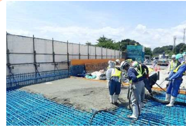
現場打設による床版打替(例)
