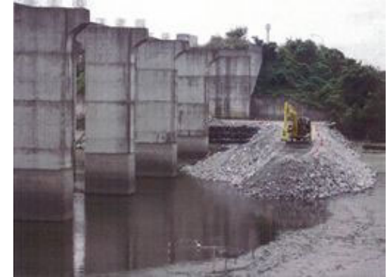
工事用道路施工状況
