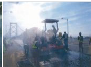
《基層グースAS舗設》
