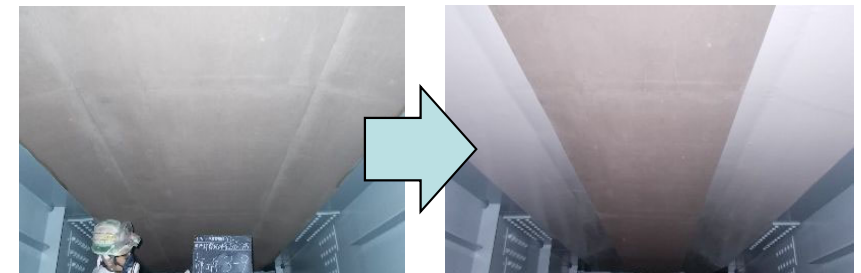
剥落防止施工前
